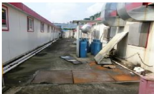
图 5-5 施工营地隔油池
