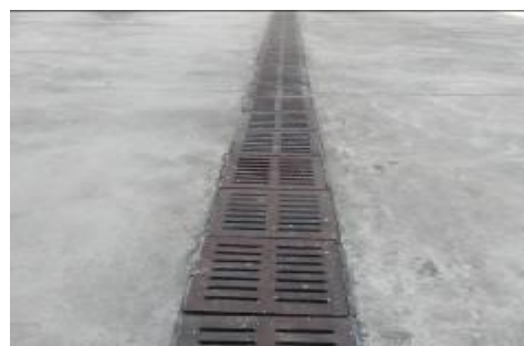
图 5-3 施工现场临时雨水沟
